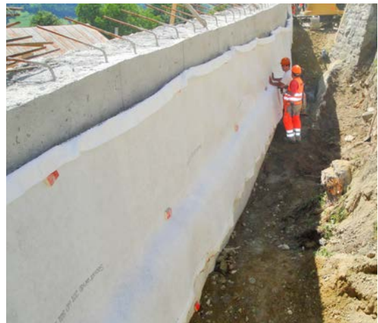
Entwässerung Stützmauer
