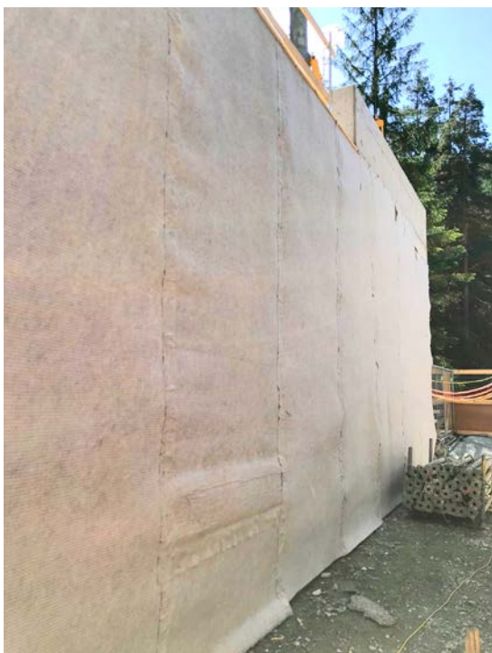
Entwässerung Bauten unter Terrain
