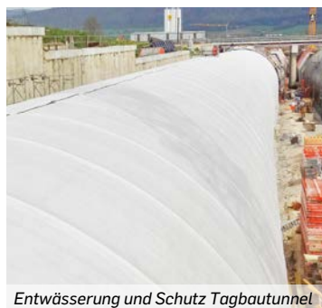
Entwässerung und Schutz Tagbautunnel
