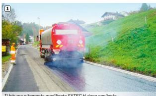
Il bitume altamente modificato SYTEC H viene applicato sulla carreggiata asciutta, pulita e fresata.
