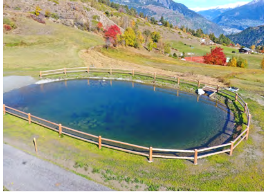
Impermeabilizzazione di bacino antincendio
