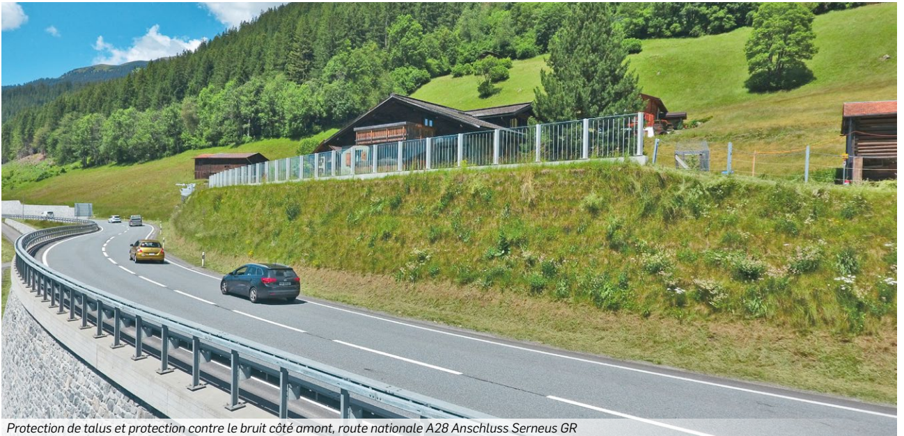
Protection de talus et protection contre le bruit côté amont, route nationale A28 Anschluss Serneus GR
