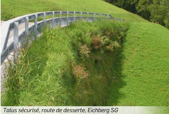
Talus sécurisé, route de desserte, Eichberg SG
