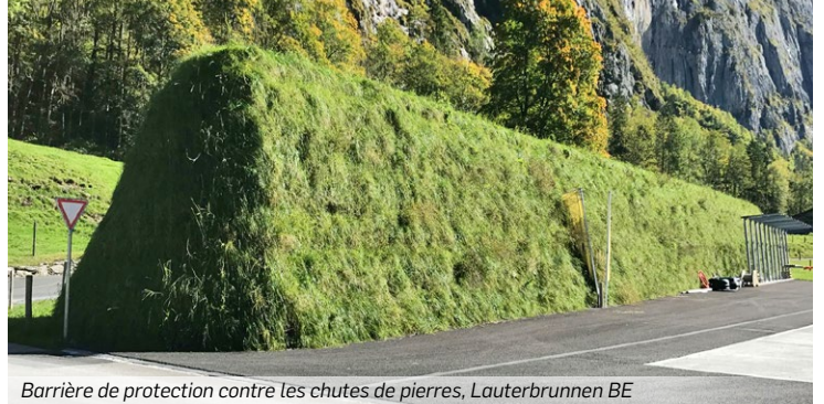
Barrière de protection contre les chutes de pierres, Lauterbrunnen BE
