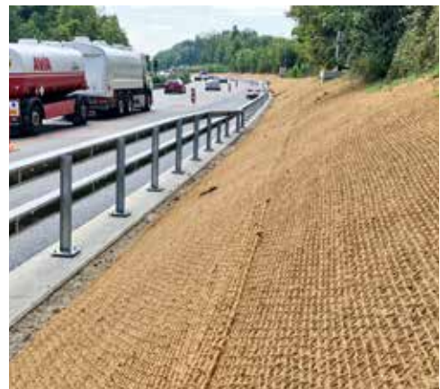
Stuoie in fibra naturale di legno, cocco o juta: protezione immediata contro l'erosione e ausilio temporaneo di attecchimento.
