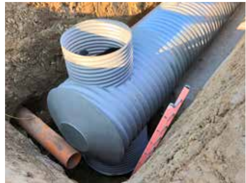
Semplice realizzazione di grandi volumi di ritenzione: canali di ritenzione SYTEC in acciaio fino a 2,2 m di diametro.
