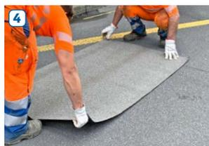
**4 Applicazione:** Rimuovere la pellicola sul retro. Posizionare SYTEC FlixFix® sul manto stradale da riparare (temperatura min. 25°C / max. 100°C).
