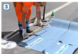
**3 Taglio:** Tagliare SYTEC FlixFix® in modo che l'area da riparare sia coperta per 10 cm su tutti i lati. Anche quando si utilizzano più strisce, occorre garantire una sovrapposizione di 10 cm.
