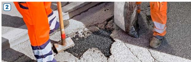
**2 Riempimento:** Colare fessurazioni con la massa di colata. Riempire le buche con miscela fredda o calda e compattare.
