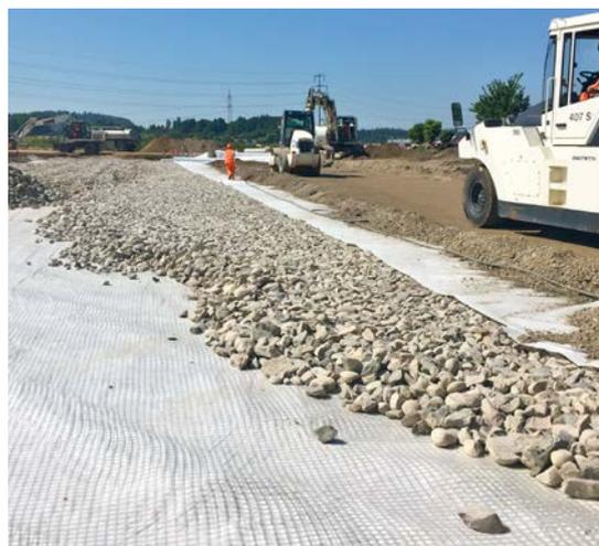
La stabilizzazione con geogriglie riduce così al minimo il movimento delle particelle all'interno dello strato di fondazione in misto granulare sotto carico ciclico. Il risultato sono sovrastrutture di vie di comunicazione a bassa deformazione.
