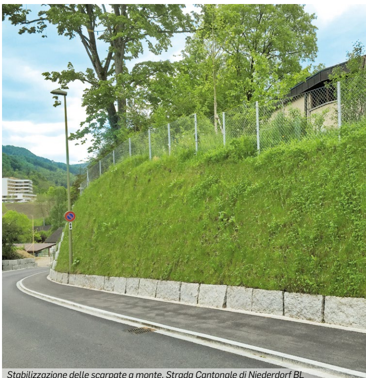
Stabilizzazione delle scarpate a monte, Strada Cantonale di Niederdorf BL
