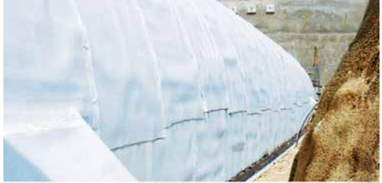
**Protection d'ouvrage:** un robuste non-tissé de renforcement protège la membrane d'étanchéité des tranchées couvertes. La combinaison avec le drainage haute performance SYTECDRAIN® évite toute infiltration.
