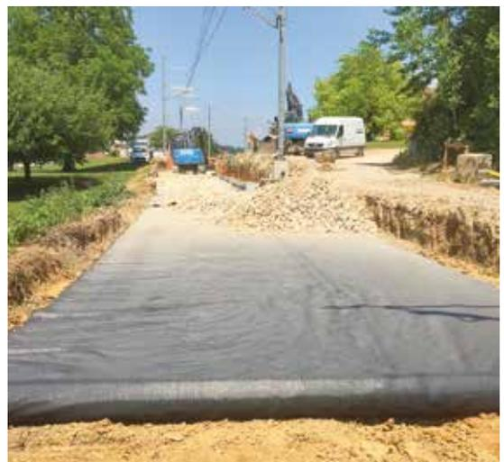
**Géotextiles de haute qualité avec une fonction de séparation et de filtration:** une contribution importante pour assurer durablement la qualité des voies de circulation
