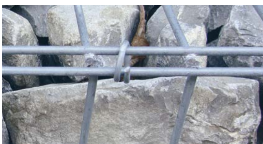
Maschinelles Verbinden mit pneumatisch eingesetzten Klammern
