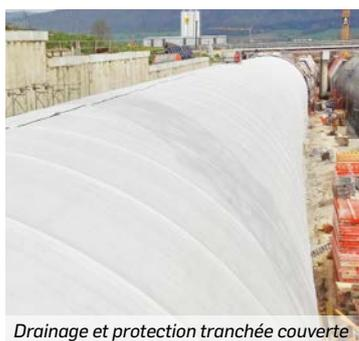
Drainage et protection tranchée couverte
