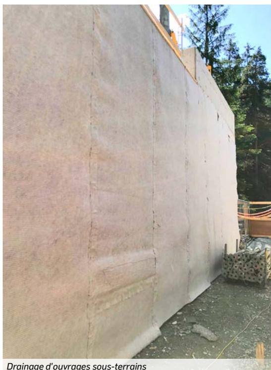
Drainage d'ouvrages sous-terrains
