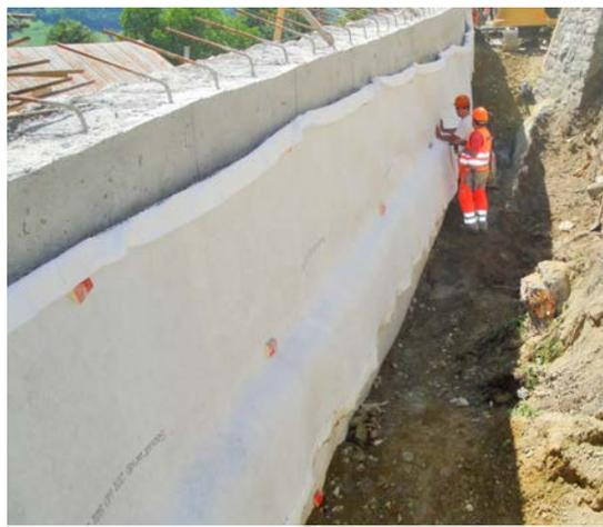
Drainage mur de soutènement
