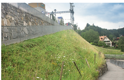
Protection contre l'érosion remblai de voie ferrée
