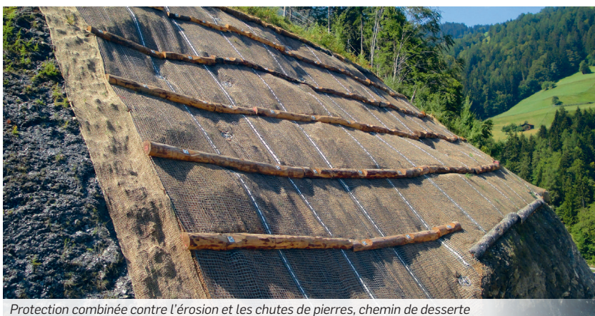
Protection combinée contre l'érosion et les chutes de pierres, chemin de dessert
