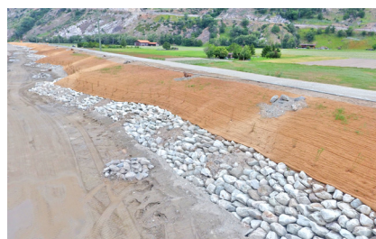
Protection contre l'érosion construction hydraulique
