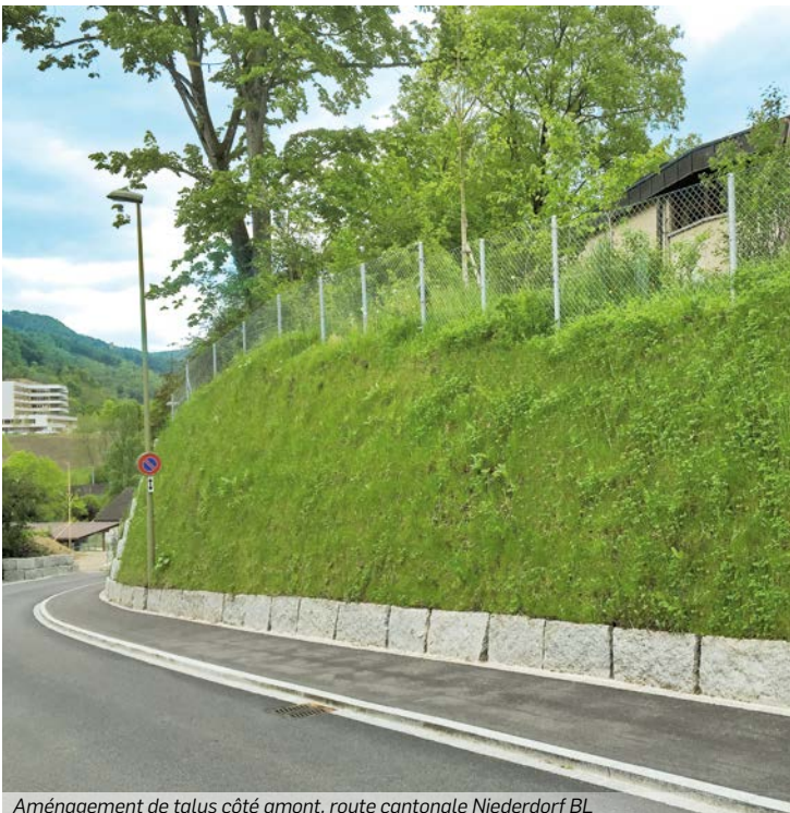
Aménagement de talus côté amont, route cantonale Niederdorf BL
