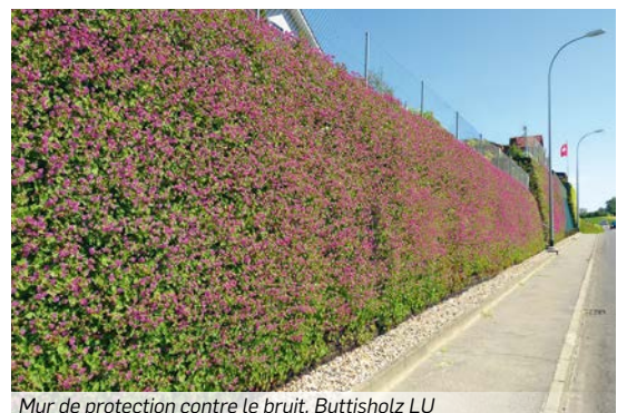
Mur de protection contre le bruit, Buttisholz LU
