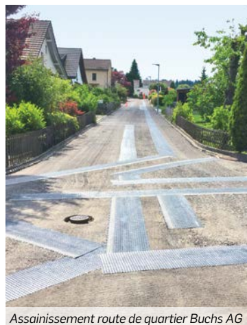
Assainissement des bords de chaussée (jonction ancienne / nouvelle couche de base)
