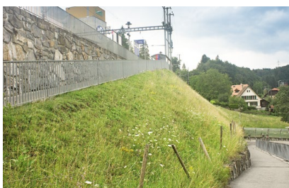
Protection contre l'érosion remblai de voie ferrée
