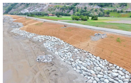
Protection contre l'érosion construction hydraulique
