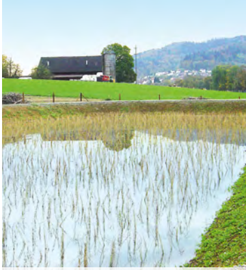
Bassin de rétention et de filtration
