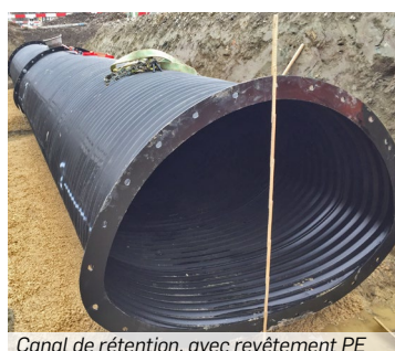
Canal de rétention, avec revêtement PE
