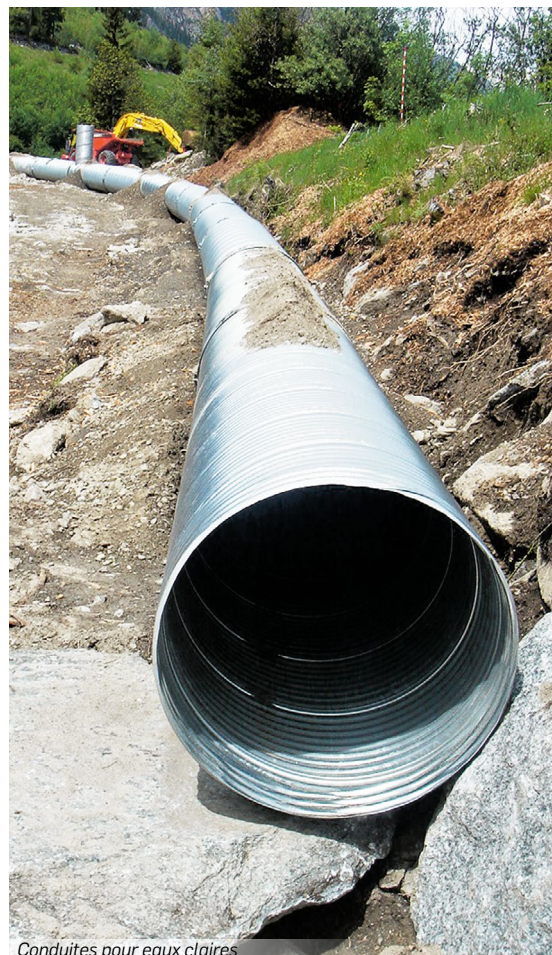
Conduites pour eaux claires
