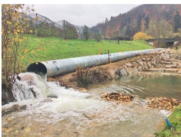
Conduite pour rivière enterrée
